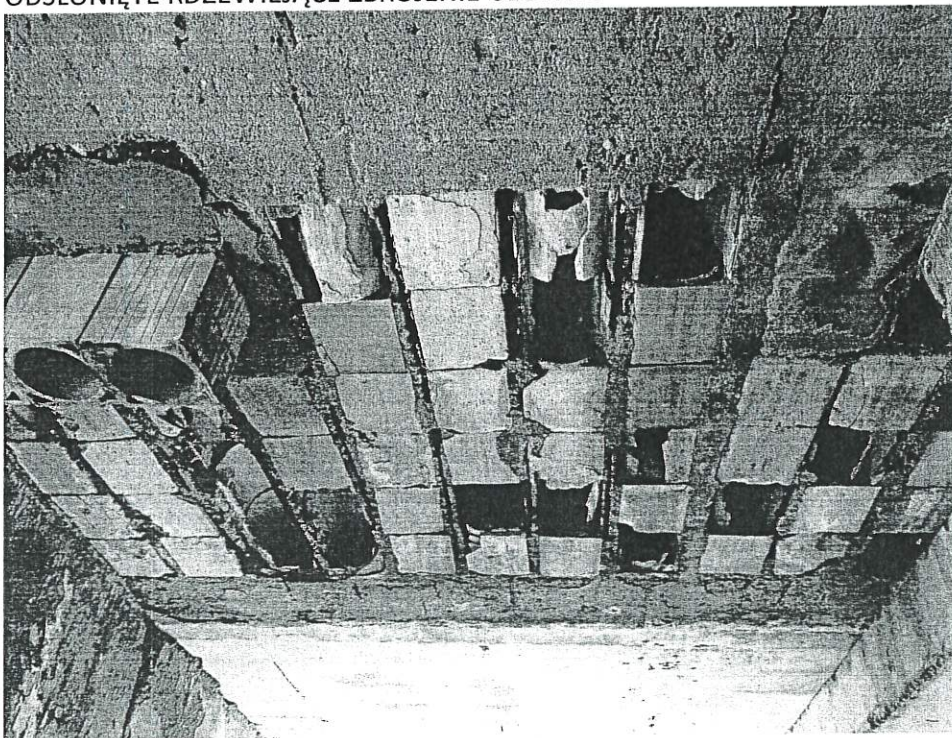
FRAGMENT STROPU CERAMICZNEGO, WIDOCZNE LICZNE UBYTKI STROPU ORAZ ODŚLONIĘTE RDZEWIEJĄCE ZBROJENIE GŁÓWNE
