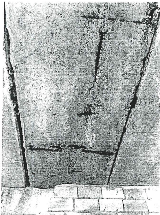
STAN WIERZCHU PŁYT I STAŁE ZALEGAJĄCA WILGOĆ SPOWODOWAŁA POJAWIENIE SIĘ MCHU NA POWIERZCHNIACH BETONU
