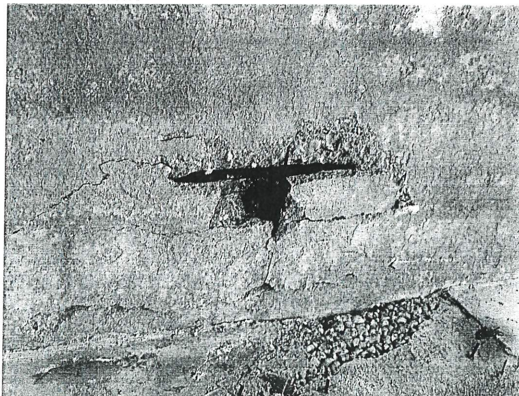
WIDOCZNE LICZNE ODPRYSKI BELEK Z UWAGI NA PRZEMARZANIE WODY WEWNĄTRZ STRUKTURY BETONU
